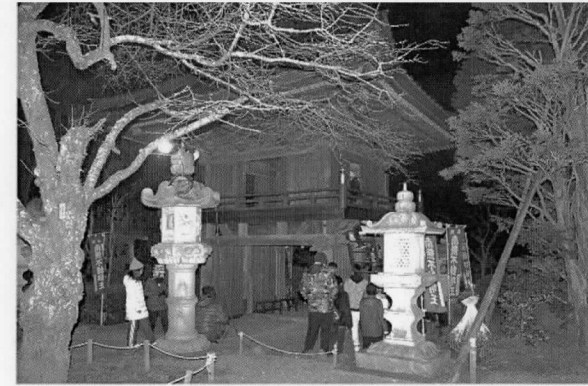
修復された鐘楼門
